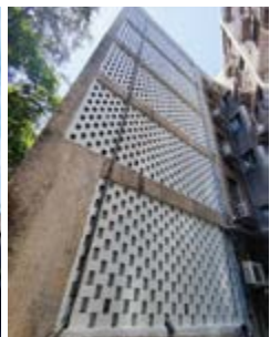
○第二宿舍曬衣間整修工程
